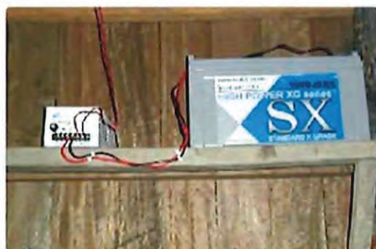
バッテリー、インバーターの設置完了。
