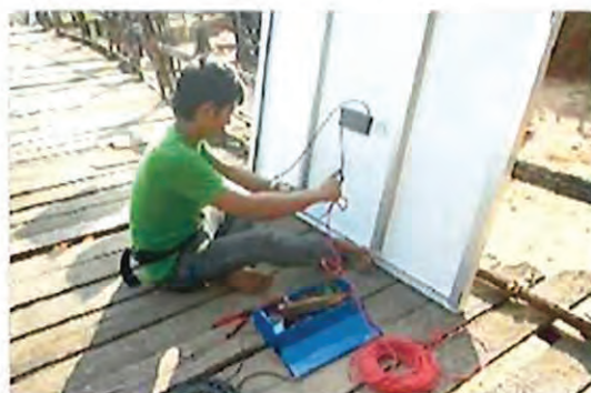
屋内配線も当然、テスターでチェックを行いながら結線していきます。
